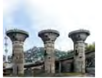
Fotoğraf 1. Merkez Lavuar Tesisleri Dekantasyon Kuleleri
