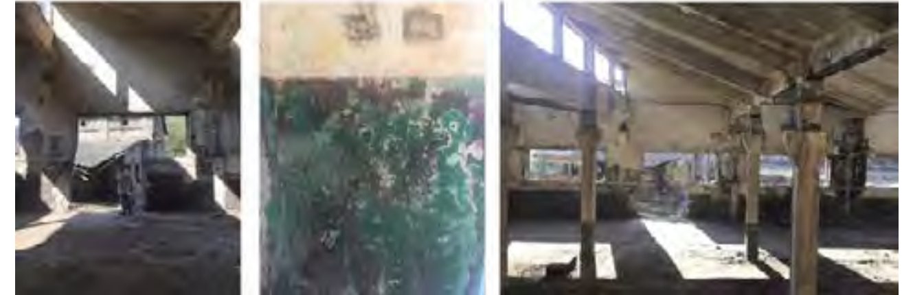
Ön (Batı) Cephesi İç Görünüşü
