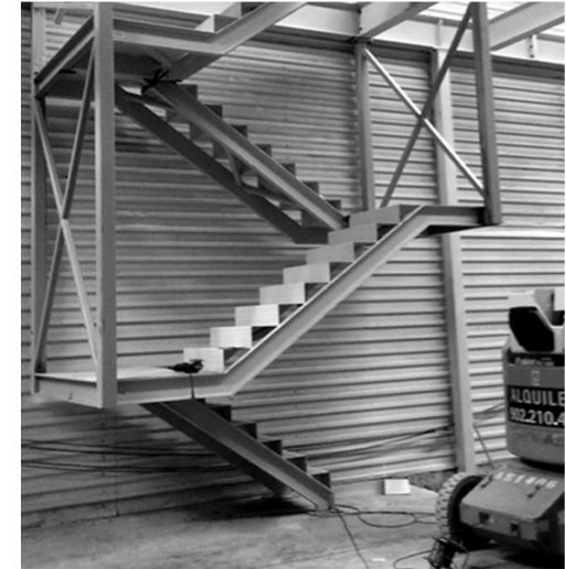
Escalera con estructura de acero
