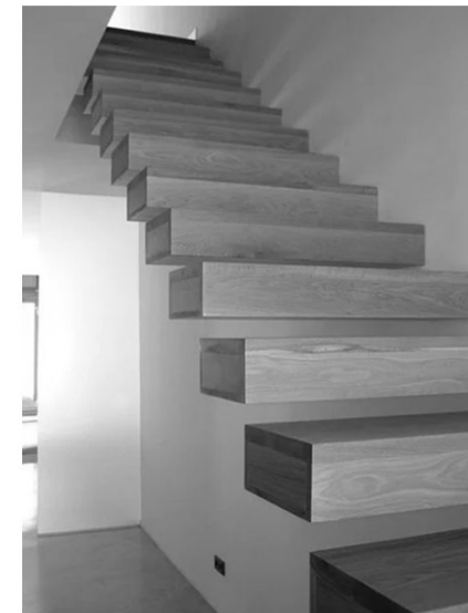
Escalera con peldaño en ménsula
