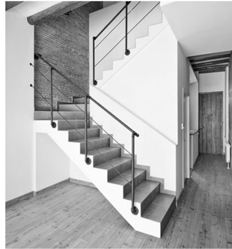
Escalera con estructura de hormigón armado
