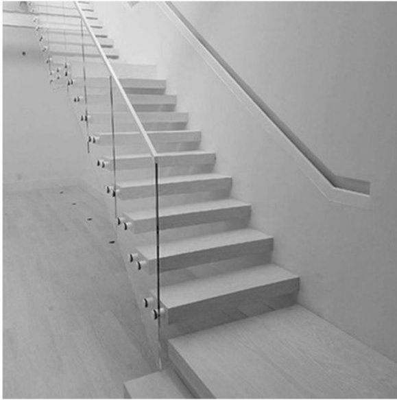
Escalera empotrada a ambos lados
