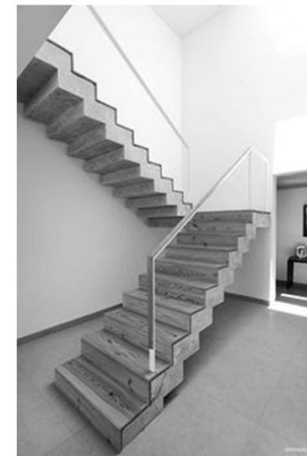
Escalera con losa apoyada
