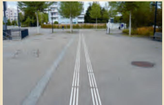
Wo auf grossen Flächen für die Orientierung erforderlich, werden taktil-visuelle Leitlinien eingesetzt. Kaltplastikmarkierungen haben einen ausreichenden Helligkeitskontrast zum Asphaltbelag.
