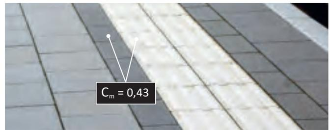
Die Sicherheitslinie weist bei trockener Oberfläche einen Kontrast von  $C_m = 0,43$  zum anthrazitfarbigen Begleitstreifen auf.
