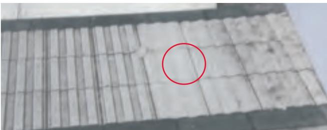
Nach Reinigung mit Bürste und Wasser ist der Kontrast mit  $C_m = 0,47$  bedeutend besser.
