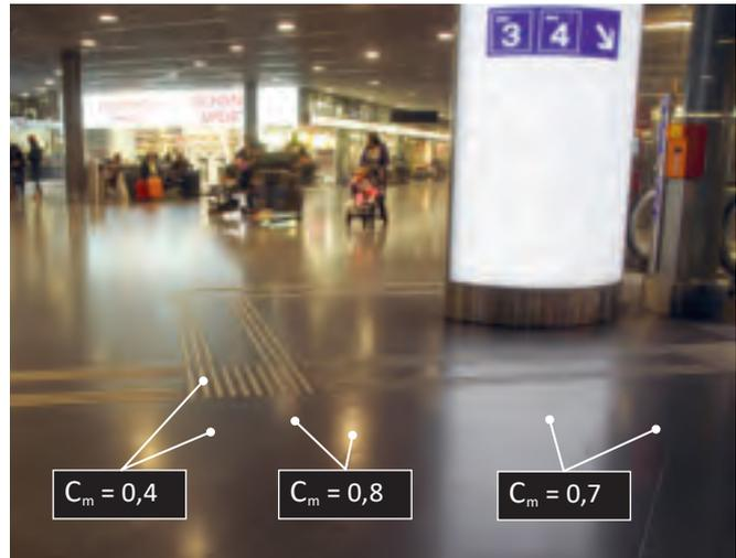
Die Lichtreflexe auf diesem spiegelnden Belag weisen höhere Kontraste auf als die taktil-visuellen Markierungen. Die Lichtsäule hat im Vergleich zur Umgebung eine sehr hohe Leuchtdichte die blendet und die Wahrnehmung der Bodeninformationen zusätzlich erschwert.
