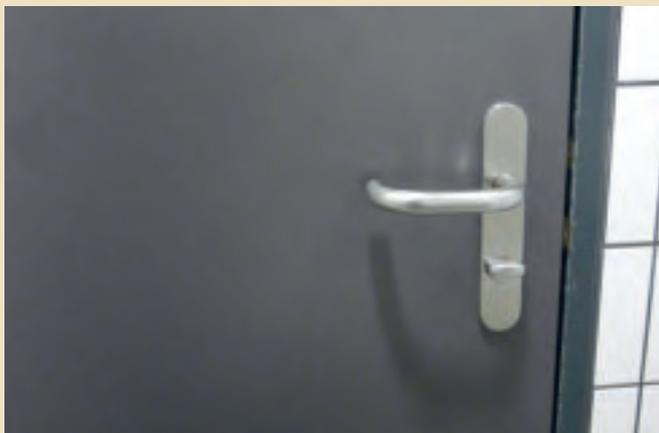
*Auf dem runden Chromstahl-Türgriff wird das Licht der Deckenbeleuchtung reflektiert und erzeugt einen guten Kontrast zum Türblatt.*
