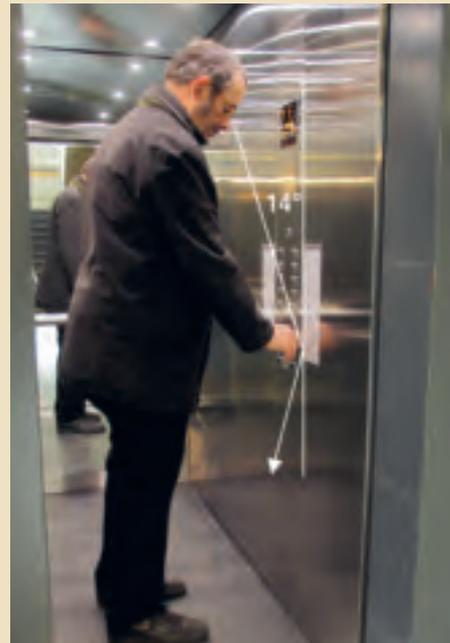
Die Ausleuchtung der Tastatur ist gering. Das Licht trifft in einem Winkel von  $14^\circ$  auf die Chromstahlplatte und wird nach unten reflektiert, also nicht zum Betrachter hin, sodass der Chromstahl als dunkle Fläche erscheint.
