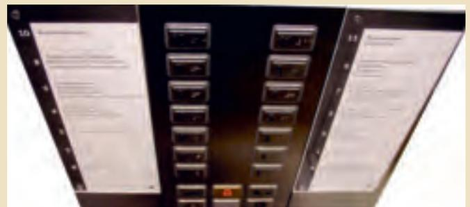
Die Tastatur hat eine Leuchtdichte von  $2 \text{ cd/m}^2$ . Bei so geringen Leuchtdichten kann das Auge Kontraste nur schwer erkennen.
