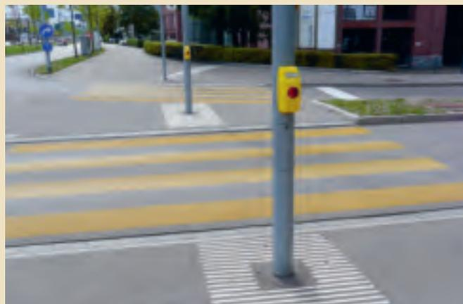
*Der gelbe Ampeldrucker und die taktil-visuelle Markierung erleichtern das Auffinden des Ampelmasts und des Anforderungsgeräts.*
