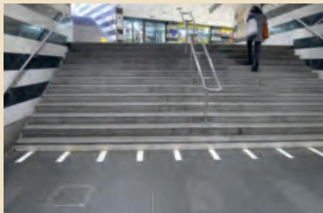
Bei der Annäherung von unten sind sowohl die Stossfläche der untersten Stufe als auch die vorgelagerten Streifen gut erkennbar.
