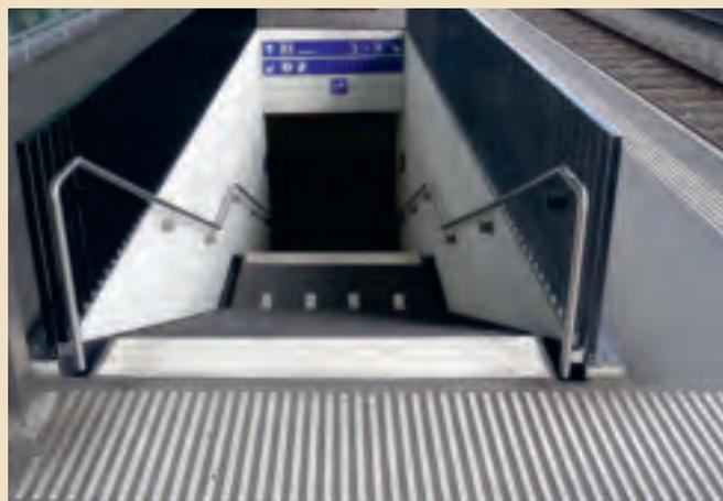
Bei der Annäherung von oben ist die vollflächig markierte erste Stufe gut erkennbar. Das Ende des Treppenlaufs wird durch die Streifen auf dem Zwischenpodest und auf dem Antrittspodest gekennzeichnet.
