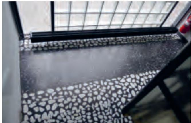
Die einzelnen Stufen dieser Treppe sind nicht erkennbar. Das sehr kontrastreiche Muster wird zudem auf dem Podest als Fries eingesetzt, wodurch eine weitere Stufe vorgetäuscht wird.
