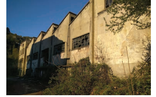
Fotoğraf 22. Üzülmez Atölye Binası
