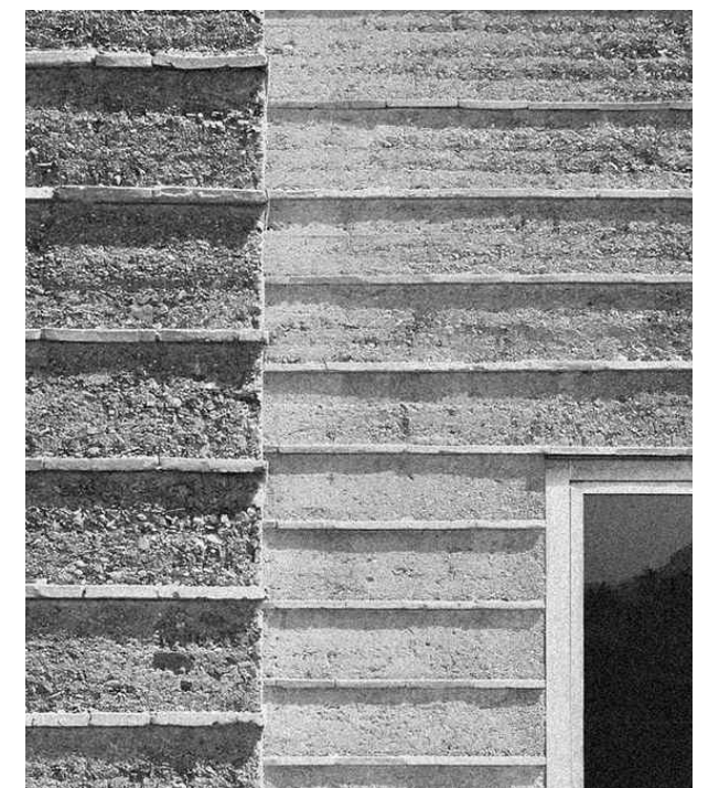
Photographie de pisée Matérialité du projet Masse thermique | Structure | Programme
