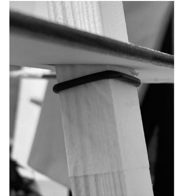
**KONSTRUKTION** Das Ameisennest besteht aus drei verschiedenen Ebenen. Der jeweilige Radius wird nach oben hin kleiner. Jede Ebene setzt sich aus acht Holzbrettern zusammen, die an ihren Enden jeweils eine Steckverbindungen besitzen. An den Steckbrettern befinden sich rechteckige Aussparungen. Durch diese Löcher werden Holzstäbe zur Verknüpfung der einzelnen Ebenen geschoben. Diese werden mit Gummiringen zusätzlich befestigt.
