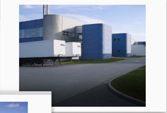
hall de production n.grimshaw, 1981
