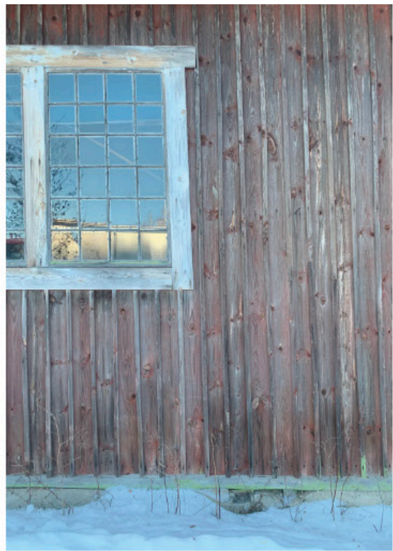
Punamultaiset julkisivut ja aikansa sahoille tyypilliset ruutuikkunat.
