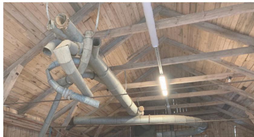
Säilynyttä koneistoa ja kattorakenteita.
