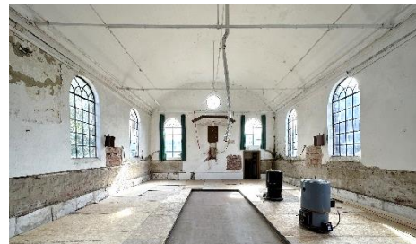
Situatie voor en na aanvang van de uitvoering (Holstein restauratie-architectuur 2017 en 2023)
