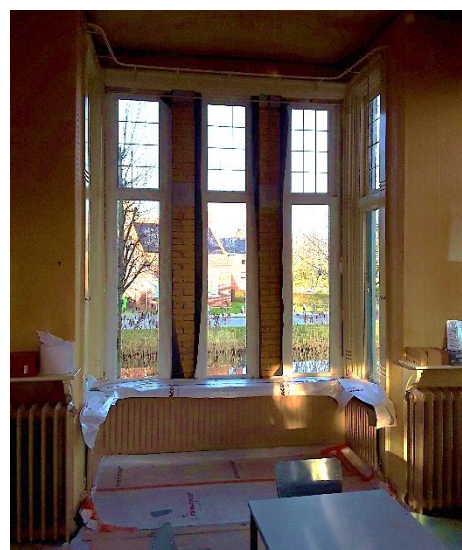
Interieur opvijzelen toren (Roffel/ HGL 2019)
