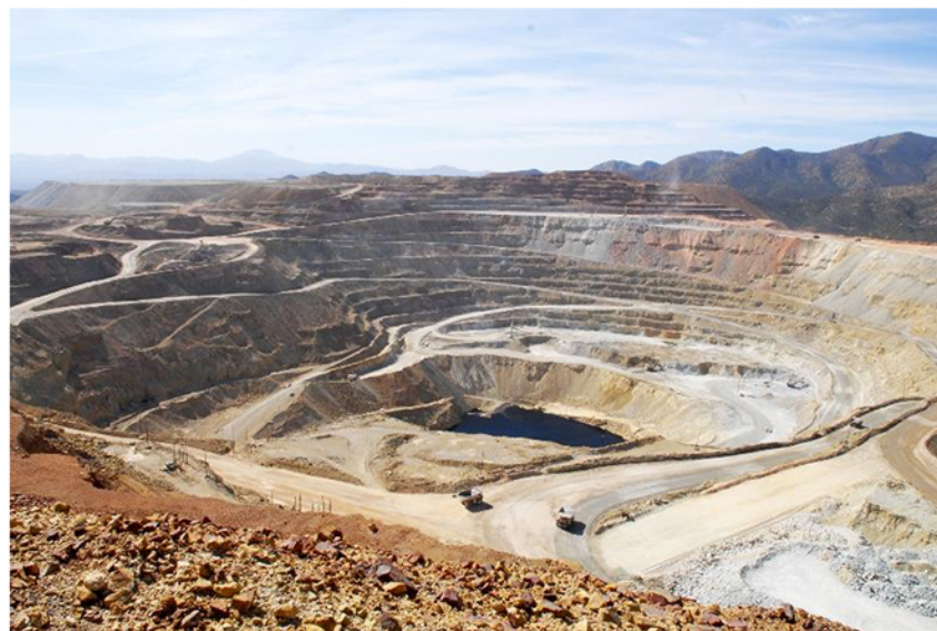
Vista de la mina Buenavista del Cobre en Cananea, Sonora, propiedad de Grupo México
