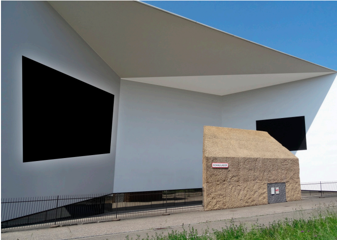
A3 | Die Hauptfassade des Schaulagers, 2023
