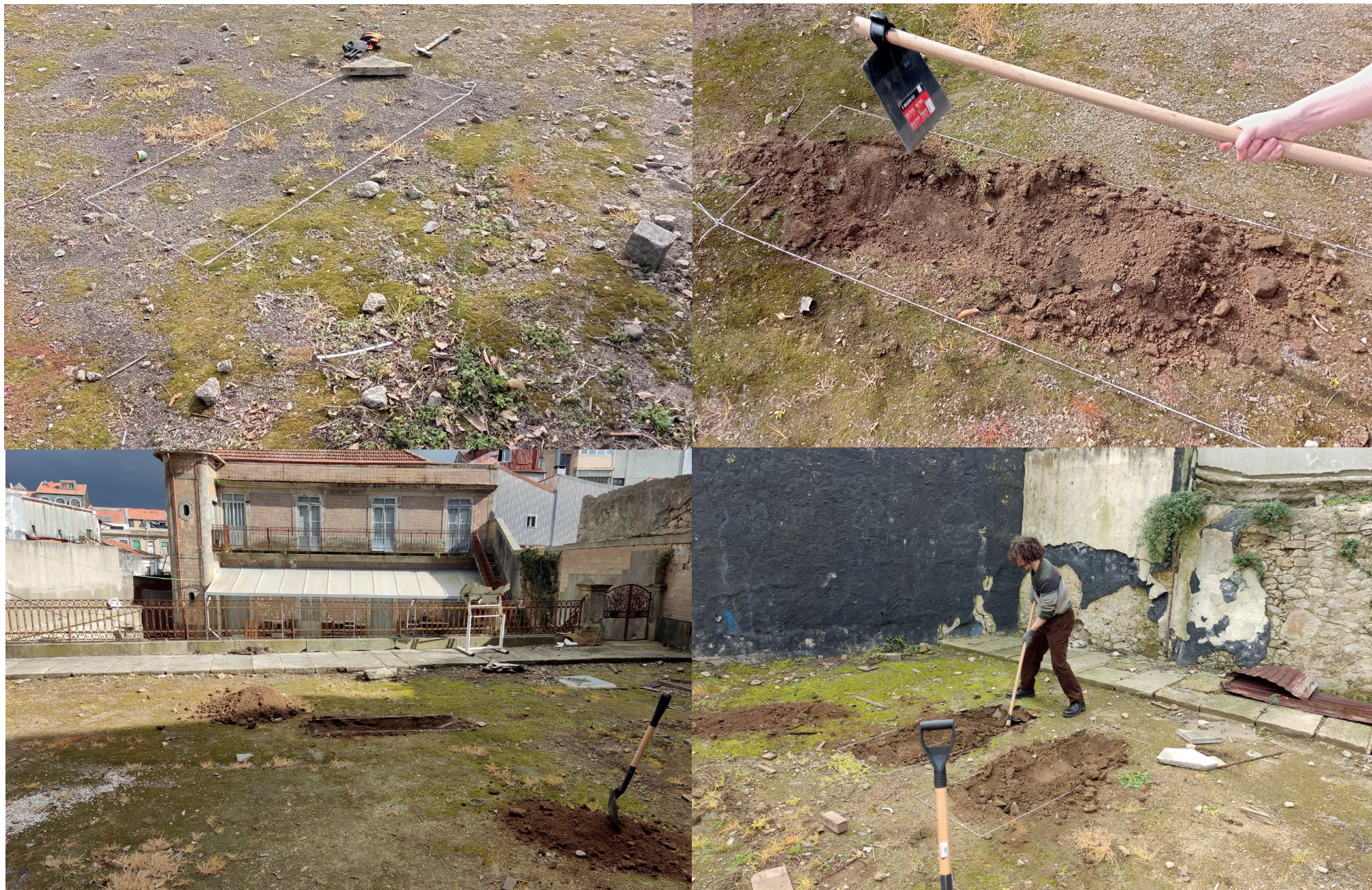
Fotografias da escavação e da construção do espaço
