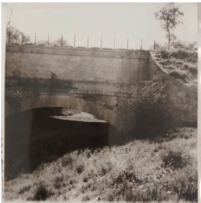
Canal de Urgel S.A. Acueducto Cervera
