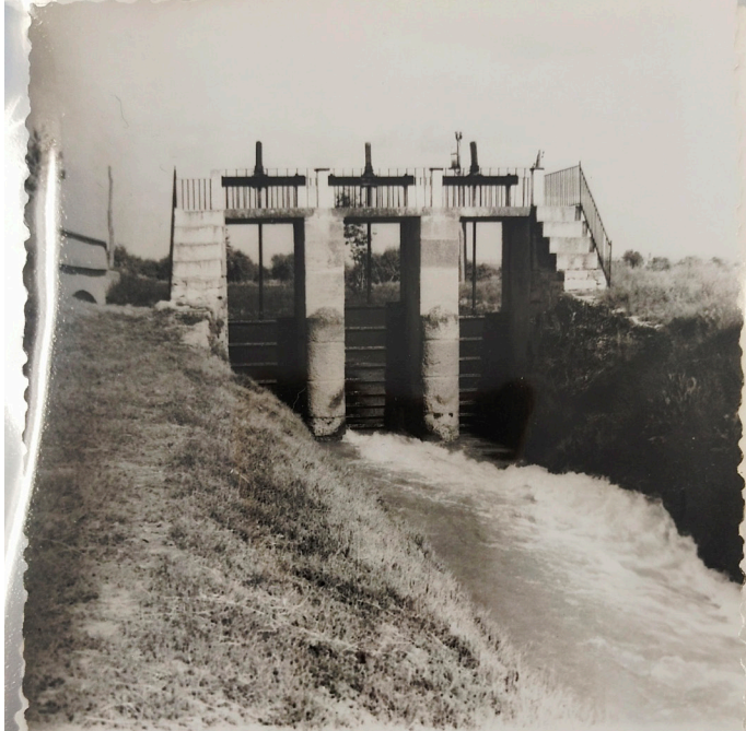
Canal de Urgel S.A. Toma 2ª Acequia Pral.
