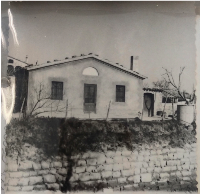
Canal de Urgel S.A. Casilla de Guarda
