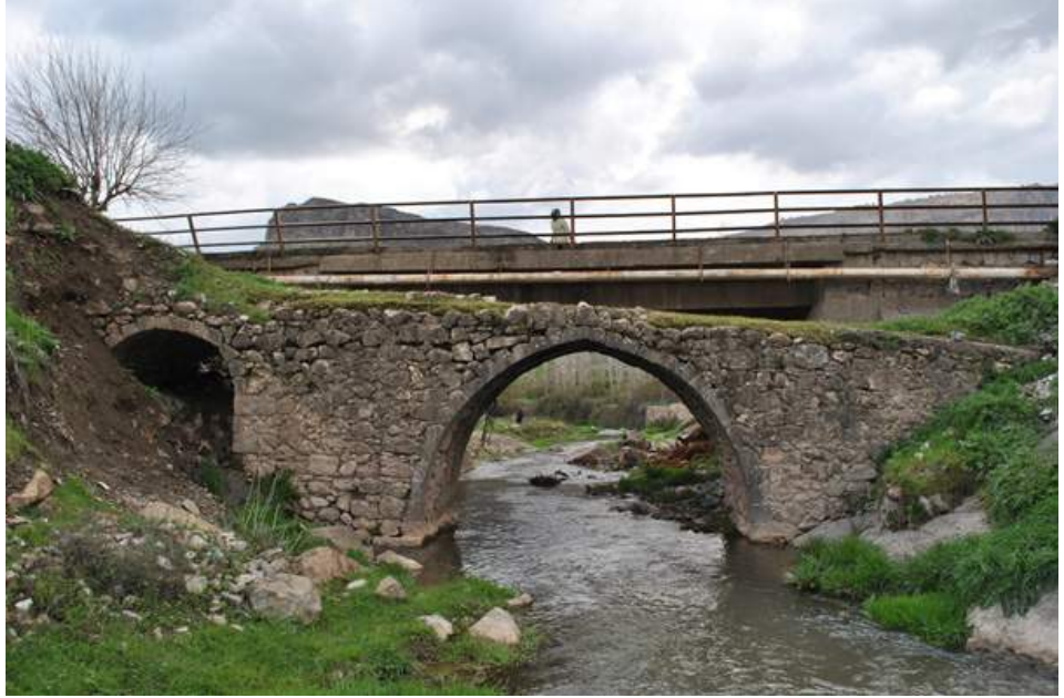
Fotoğraf 12. Nişnik Köprüsü
