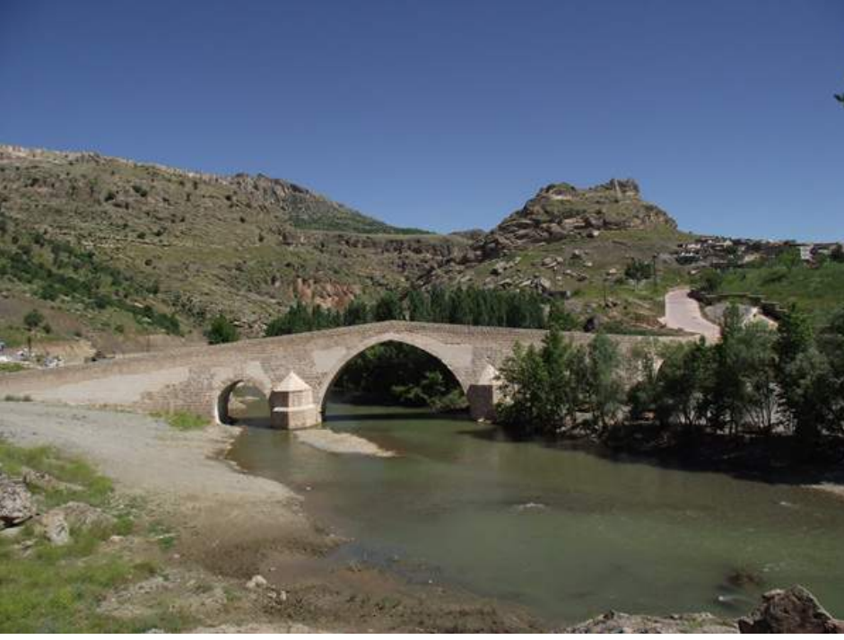
Fotoğraf 9. Haburman Köprüsü
