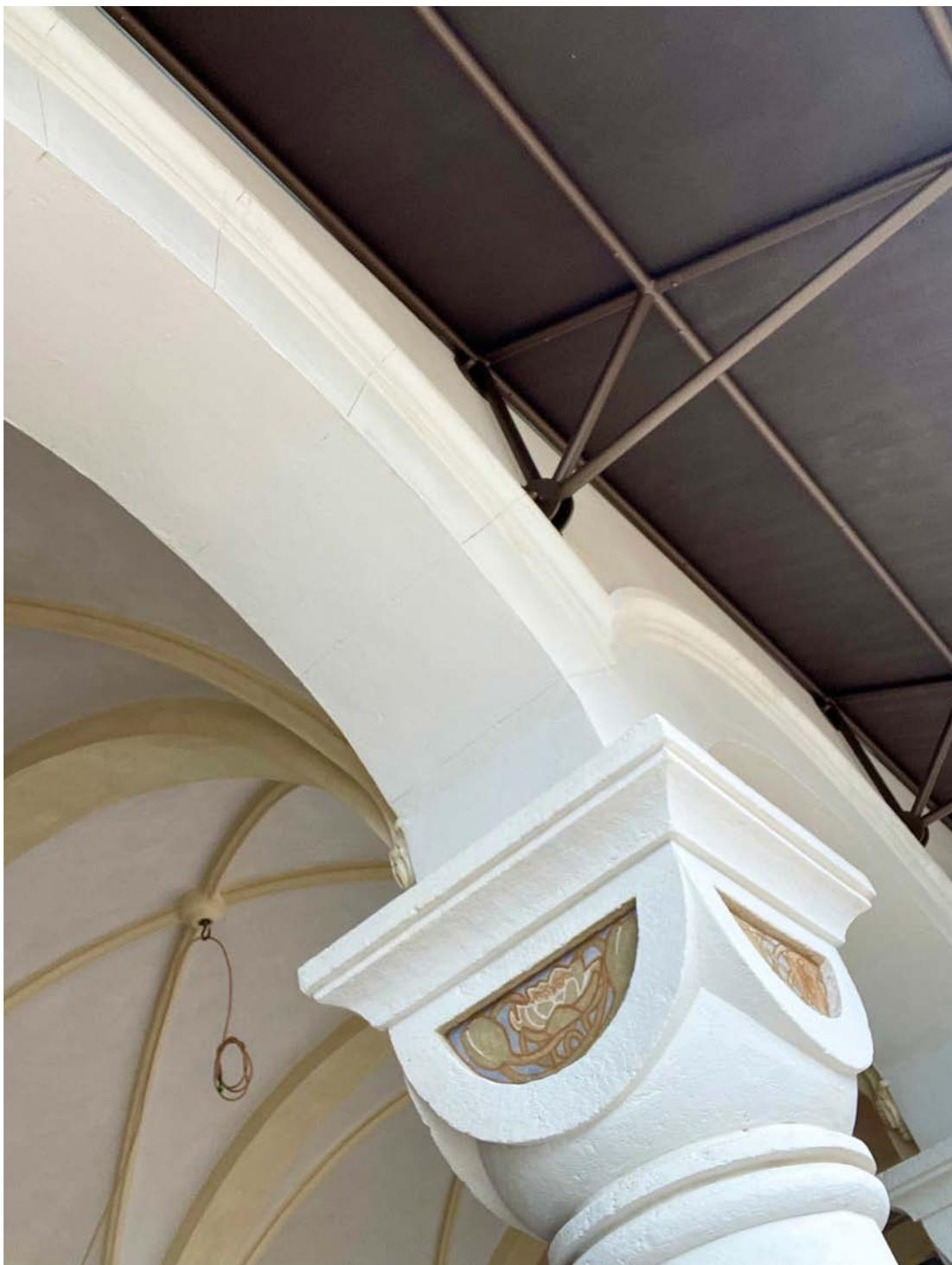
Ein neues, leichtes Vordach schützt die Malereien. Seine Konstruktion aus runden Stahlrohren schreibt die Rhythmik und filigrane Plastizität des (nicht konstruktiven) Kreuzrippengewölbes als losgelöste, eigenständige Spiegelung fort.
