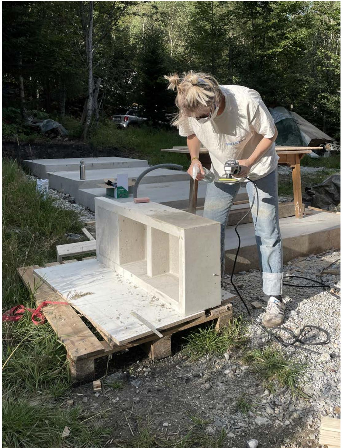
Das Waschbecken wurde von unserer Mitarbeiterin Agnes geschalt, aus einem selbst gemischten Beton mit Abbruchmaterial als Zuschlag gegossen, geschliffen und versiegelt. Reparieren bedeutet für uns in diesem Projekt nicht nur mit angemessenen Mitteln zu planen. Um einfache Lösungen zu realisieren sind wir selbst handwerklich aktiv geworden.
