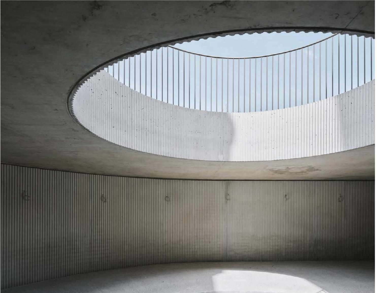
Der von oben belichtete Zentralraum der Bestandsvilla wird in der neuen unterirdischen Zugangsebene als uneindeutige Kopie zitiert. Dort mit Stuckwänden und Holzvertäfelung. Hier wellenförmig abgeschalt.
