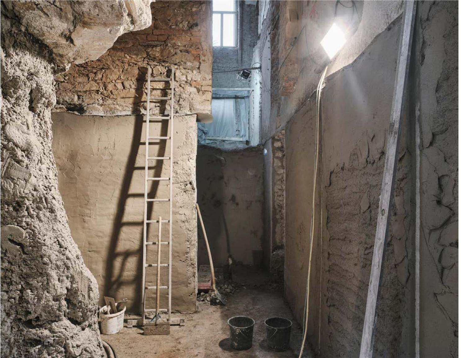
Das nordwestliche Eckzimmer im Tiefparterre der Villa wurde auf das neue Zugangsniveau abgegraben. Das daran anschließende Stiegenhaus wurde auf die neue Geschoßebene nach unten geführt und daran anschließend wurde ein Lift eingebaut, der alle Geschoße miteinander verbindet.
