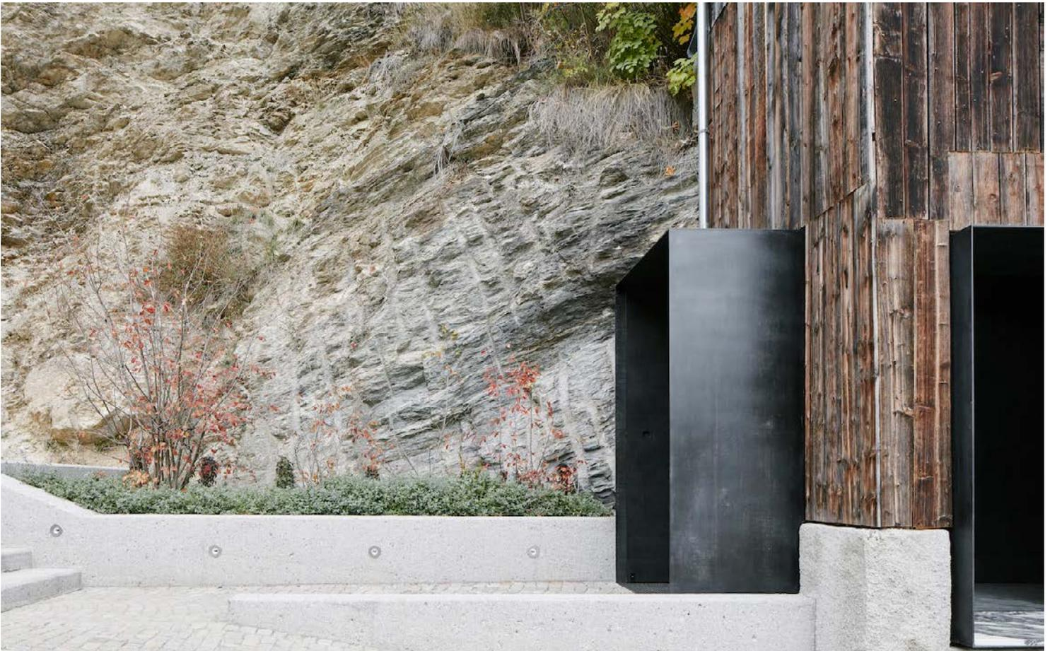
Im Bereich des ursprünglichen Zugangs zum Schlauchturm formt die eingesetzte Schale eine Sitznische. Parallel zur Straße wurde – von Stützmauern flankiert – ein neuer barrierefreier Zugang geschaffen.
