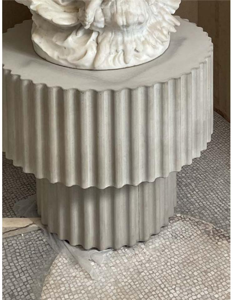
Der Mosaikboden und die mit Stucco und Holzvertäfelung überzogenen Wände des Zentralraums lassen keine Klimatisierung über Bauteilaktivierung zu. Der historische Sockel der zentral positionierten Statue wurde durch einen neuen Sockel ersetzt, über welchen klimatisierte Luft aus dem Tiefparterre in den Raum geblasen wird. Mit einem minimalen Eingriff konnte ein angemessenes Raumklima geschaffen werden.
