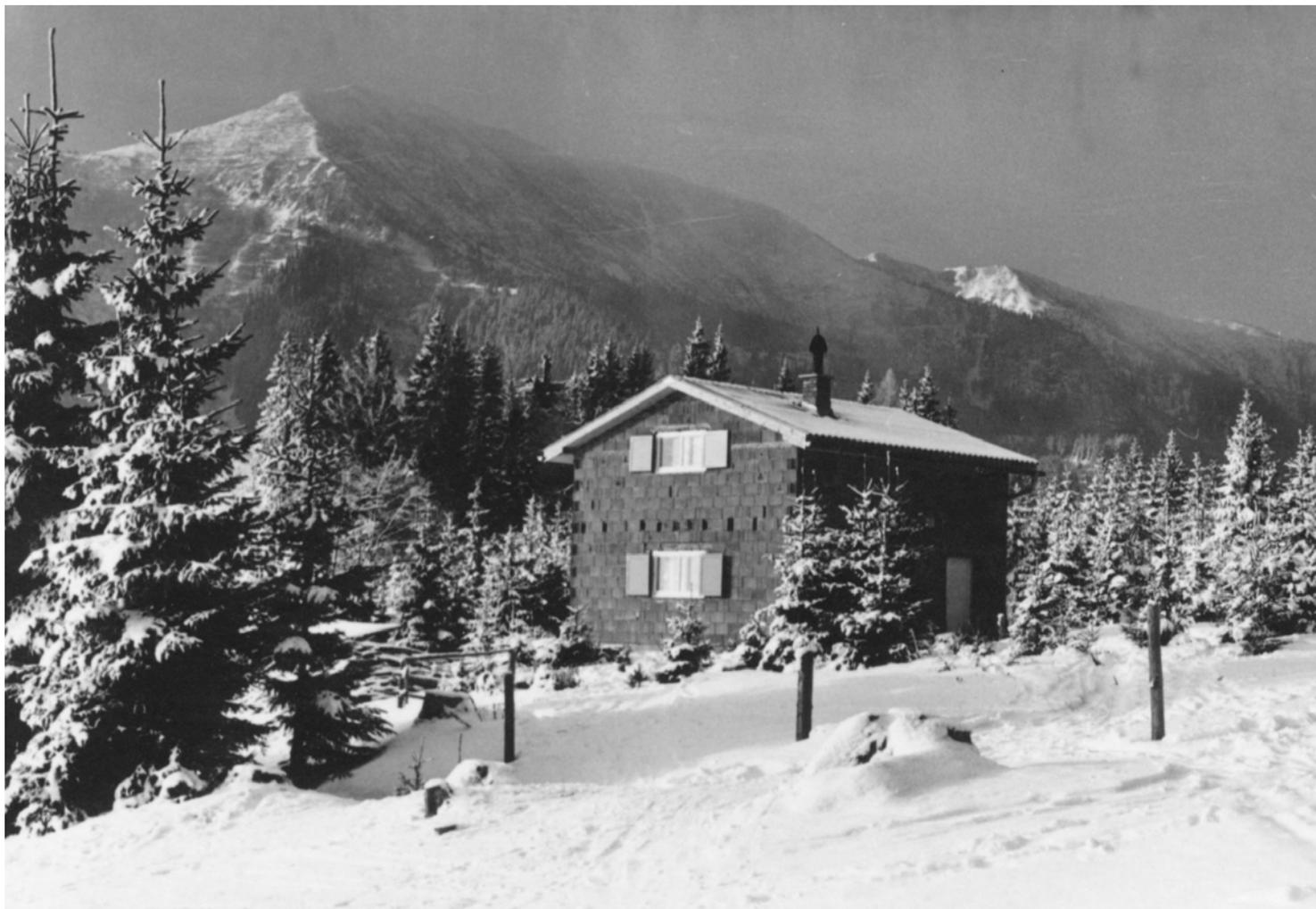
Die Hütte wurde in den 60er Jahren mit einfachen Materialien – Zementziegel für die Wände und Holz für Decke und Dach – in Eigenbau errichtet.
