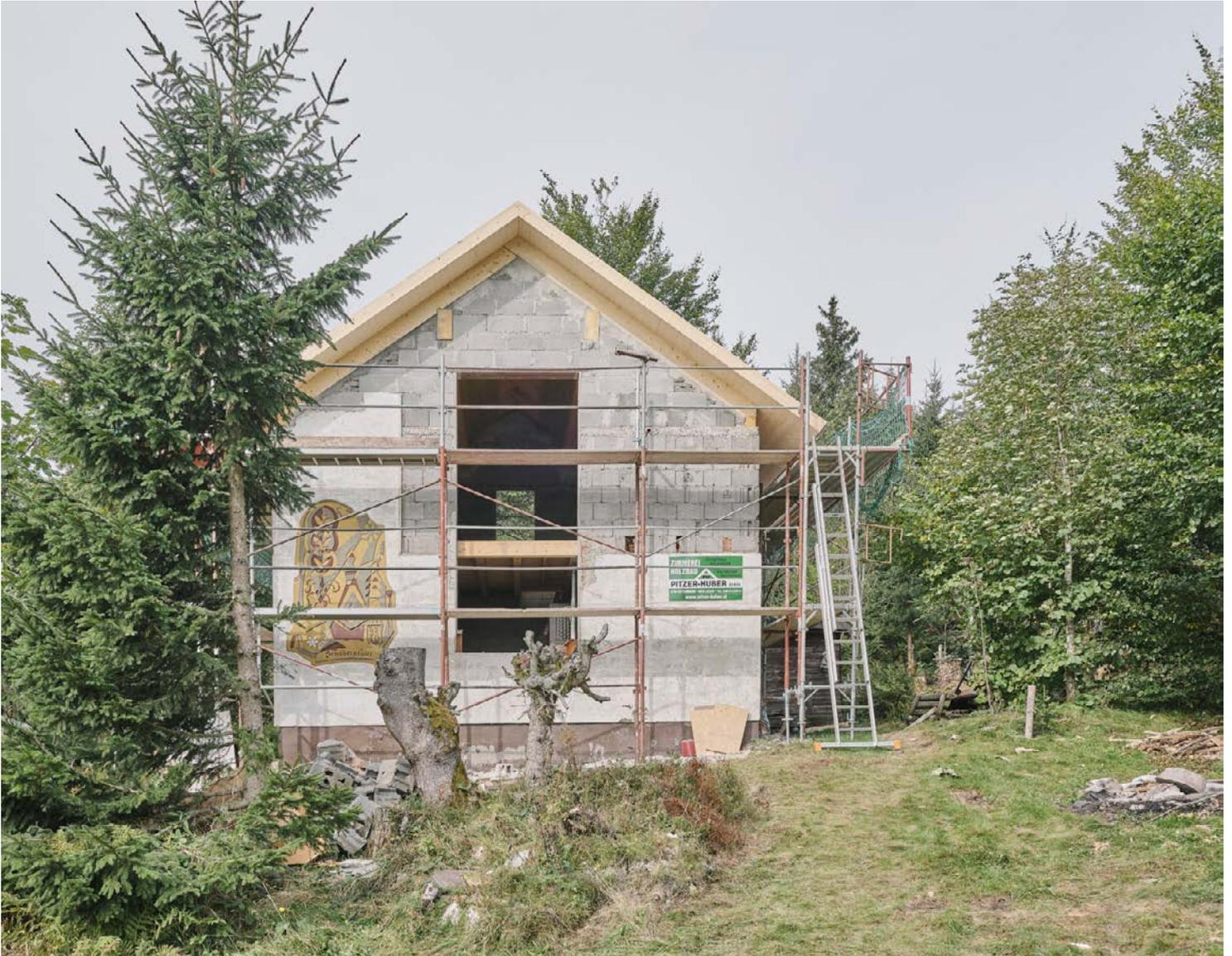
Die steilere Dachneigung bewirkt, dass der Schnee abrutscht, wenn im Winter über längere Zeit niemand vor Ort ist. Zugleich wird die weithin sichtbare Ostfassade neu proportioniert. Eine große Öffnung verbindet nun die ehemaligen zwei horizontalen, kleinen Fenster. Sie wird noch mit großen Fensterläden versehen werden und erinnert an ein Scheunentor.
