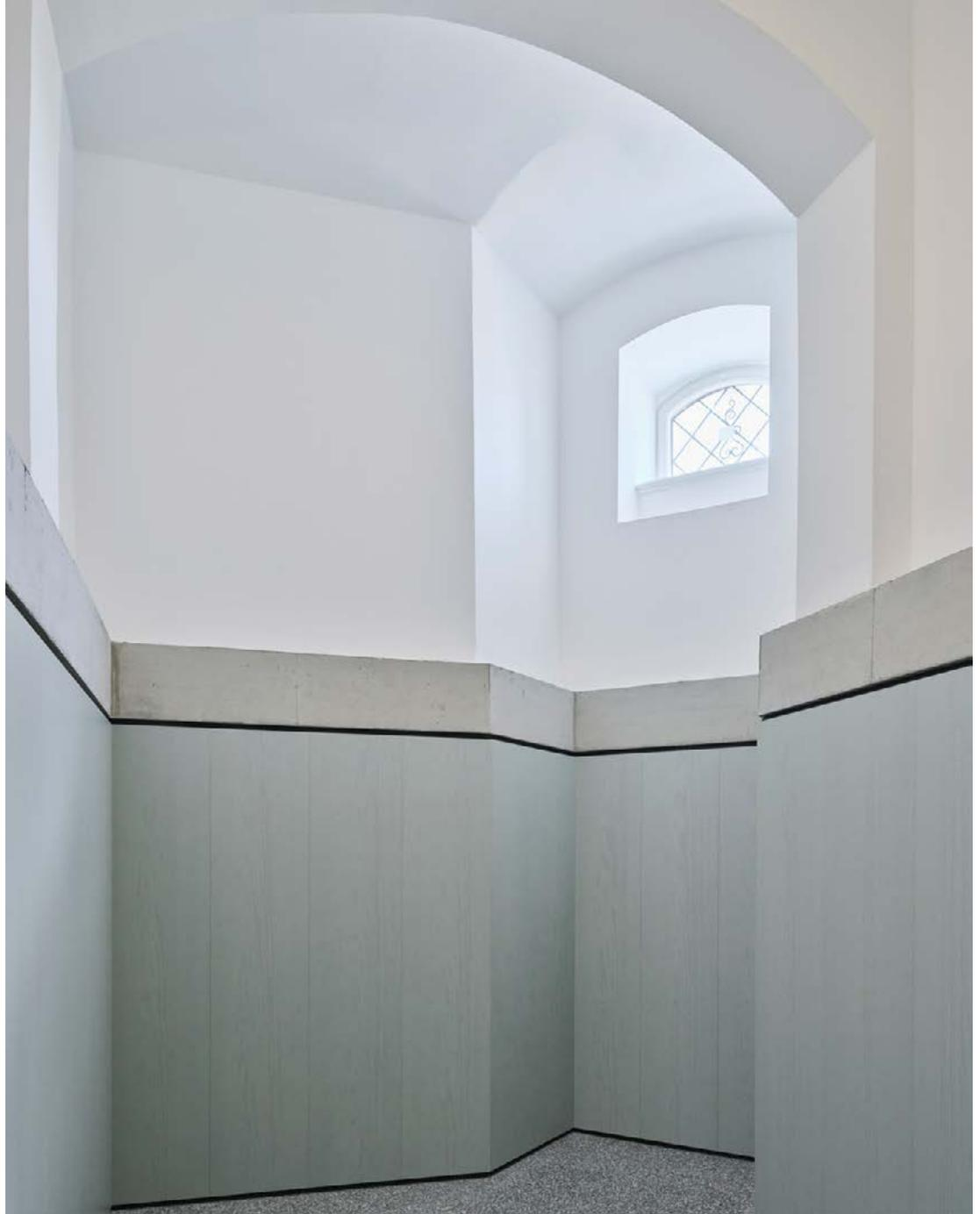
Das neue großzügige Entree auf Sockelebene erhält natürliches Licht über das Eckfenster und kommuniziert auf zwei Ebenen mit dem Stiegenhaus. Der Betonkranz – auf Ebene des ursprünglichen Bodenniveaus – fängt die Gurtbögen des Gewölbes ab.
