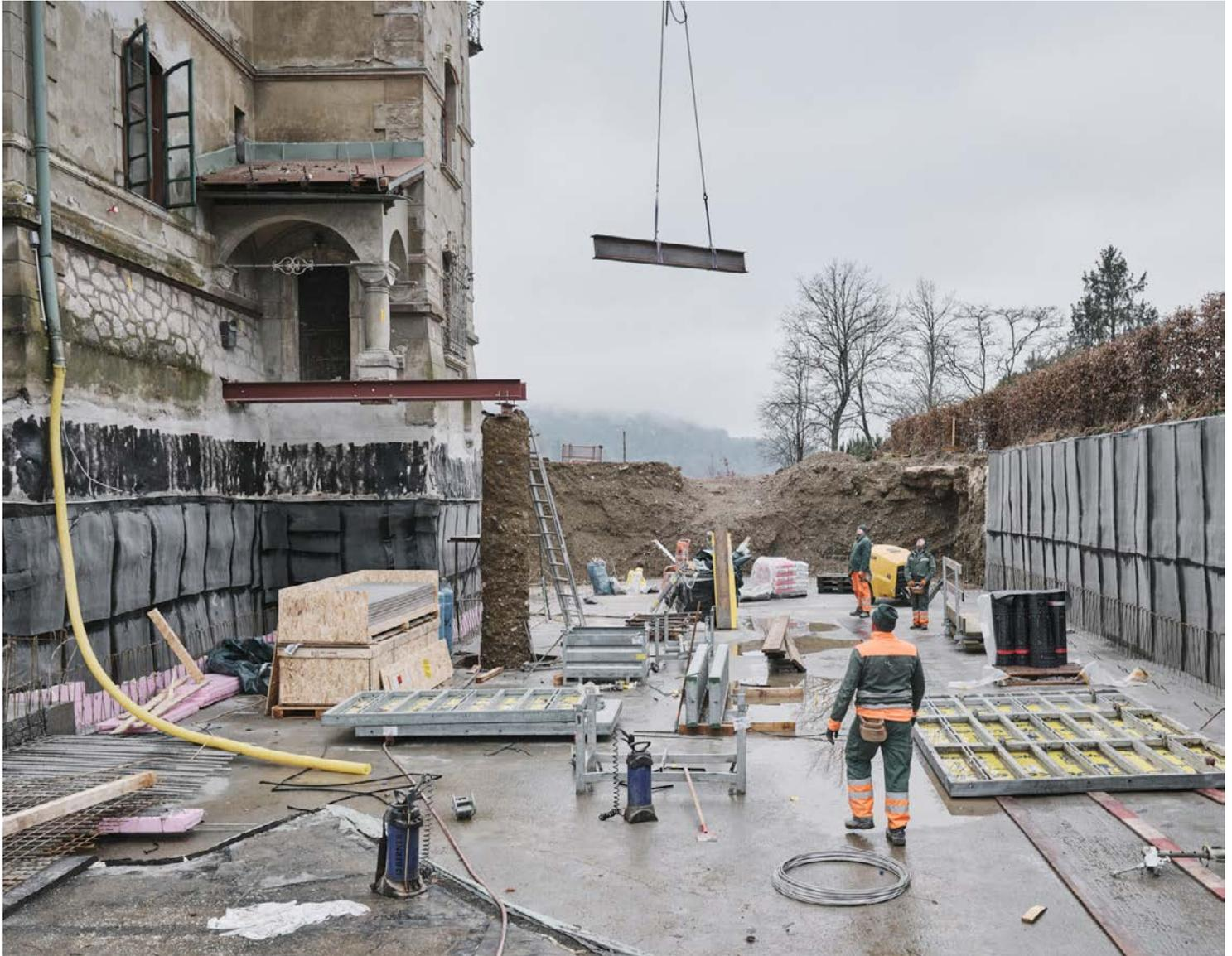
Zur Realisierung der neuen unterirdischen Sockelebene wurde die Villa mittels Düsenstrahlverfahren unterfangen. Kurzzeitig stand die Säule der Überdachung des historischen Haupteingangs auf einer baulichen Krücke.
