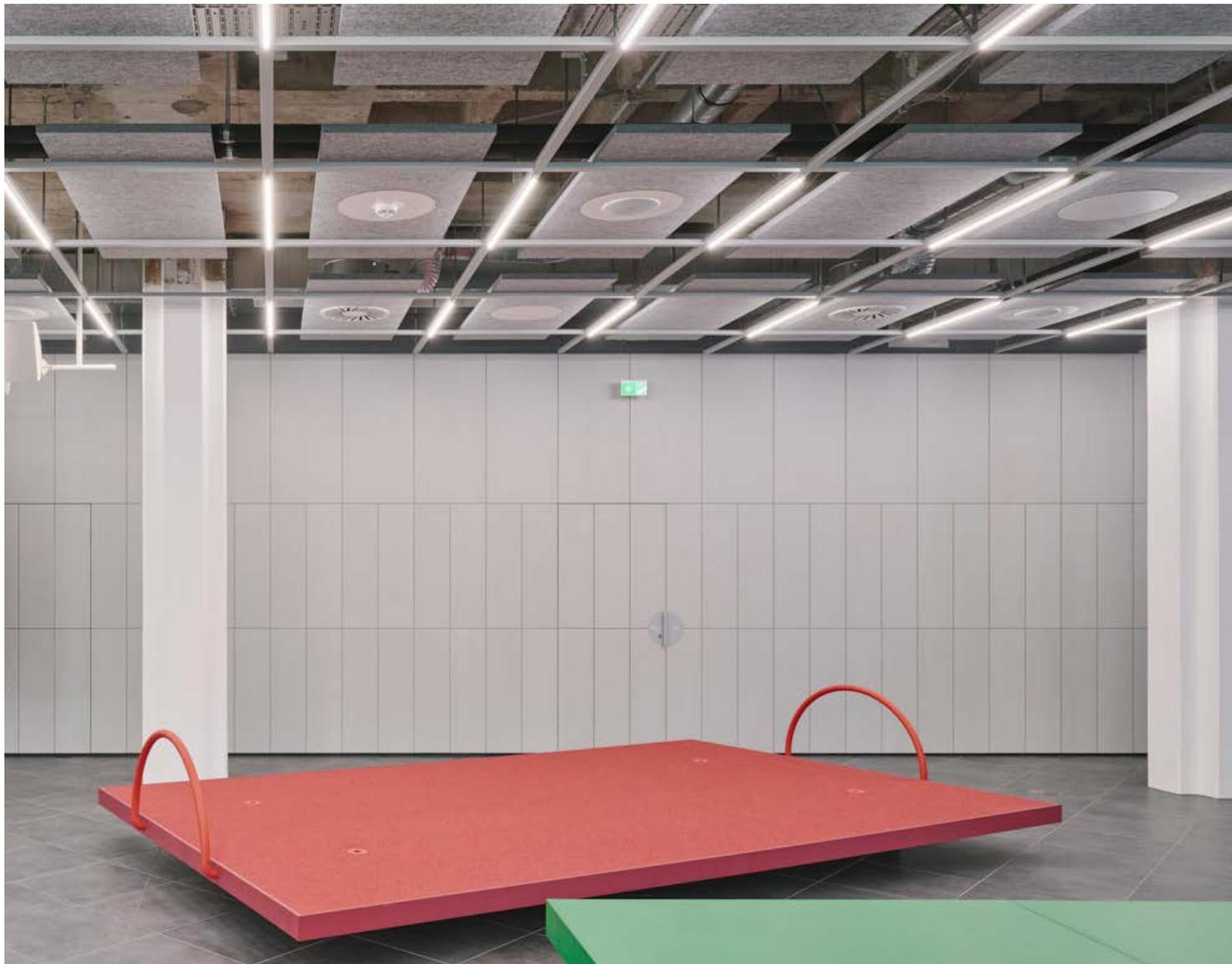
Die Rohbetondecke sowie die verbaute Technik bleiben sichtbar. Auf den filigranen Aluminiumprofilen, welche die linearen Leuchten tragen, liegen Akustikpaneele. In regelmäßigen Abständen sind sie mit kreisrunden Einsätzen bestückt – für Lüftungsauslässe, Lautsprecher, Brandmelder und Notlichter.
