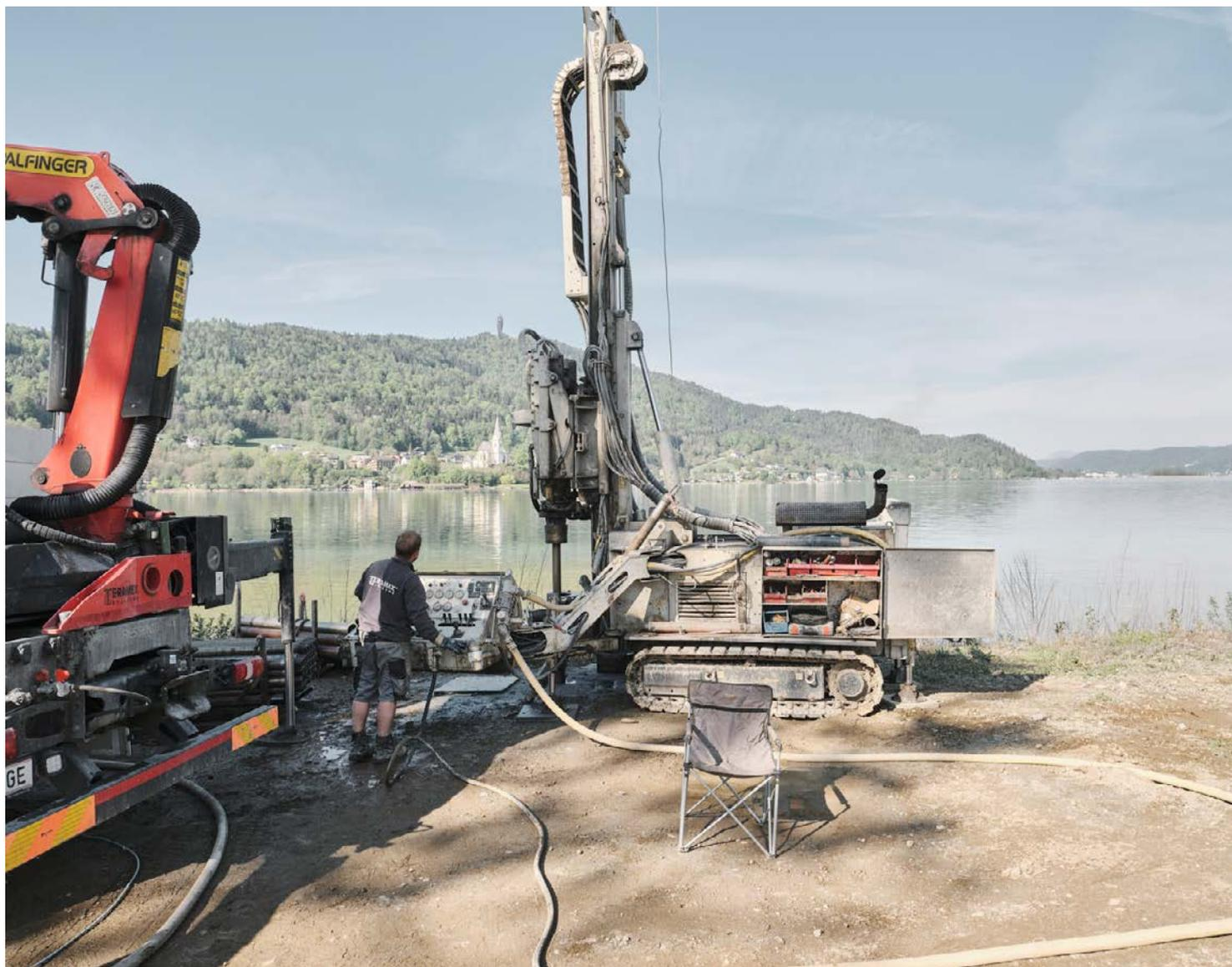
Das warme Wasser in den Wandheizschleifen wird über eine Wärmepumpenanlage aufbereitet und im Haus verteilt. Dafür wurden im Uferbereich Tiefenbohrungen durchgeführt. Mittels Erdsonden wird Erdwärme aus dem Erdreich entnommen.
