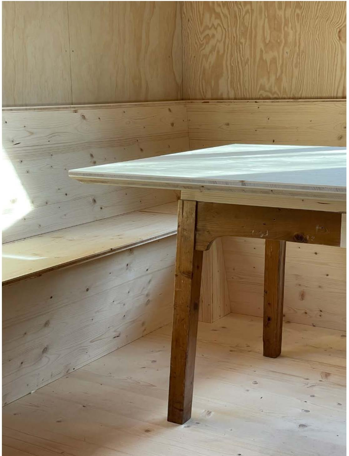
Nicht nur in der Primärstruktur ergänzen sich bestehende Elemente mit hinzugefügten. Auch im Ausbau verbinden sich wiederverwendete Bestandsfragmente mit den neuen Fichtenholzplatten.
