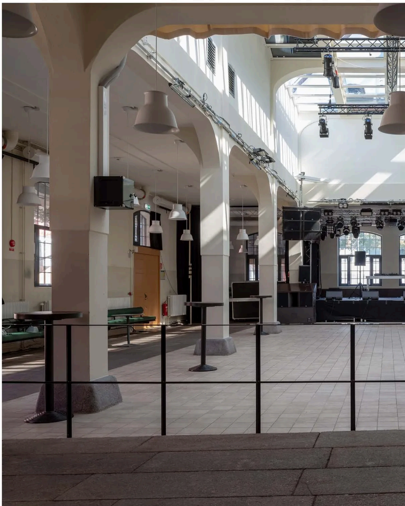
En stor del av ombyggnaden har handlat om att riva tillägg som gjorts sedan uppförandet, som bjälklag och installationer, för att åstadkomma ett ljus öppet rum.
