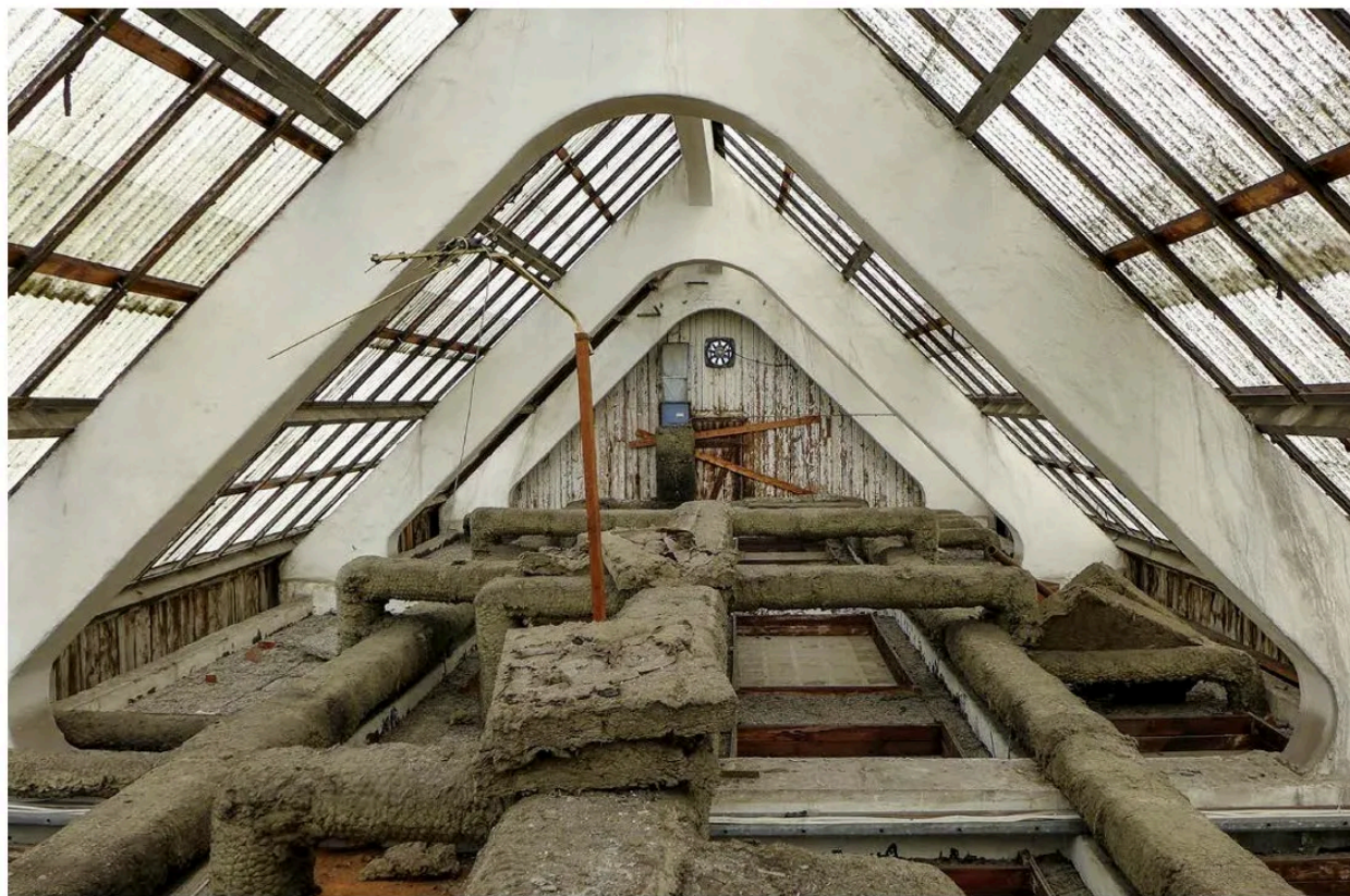
Byggnaderna uppnådde ett sekels bruksskick innan renoveringarna inleddes. Foto: Lina Karlsson
