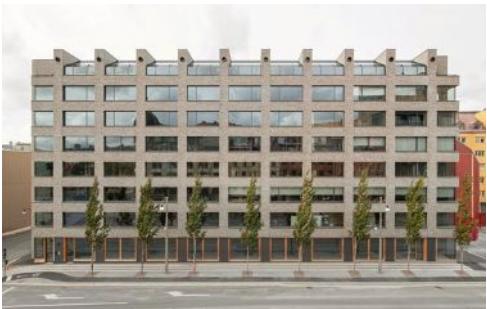
Merkurhuset i Göteborg är nominerat till Kasper Salin-priset. Foto: Mikael Olsson
