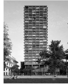
Boltshauser Architekten, Hochhaus H1 Zwhatt-Areal, Regensburg, 2023
