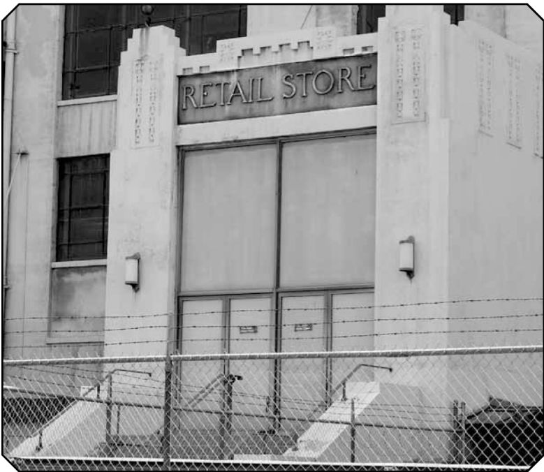
UNA DE LAS ENTRADAS del edificio, junto al área de recogido de mercancía.
